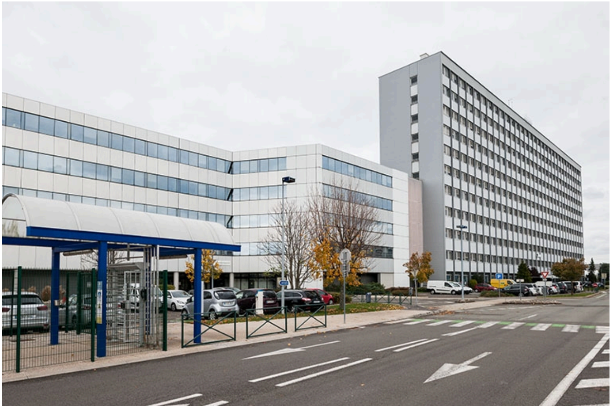
Entrée ouest. Bâtiments administratifs et Centre de recherche (Building Ouest).
