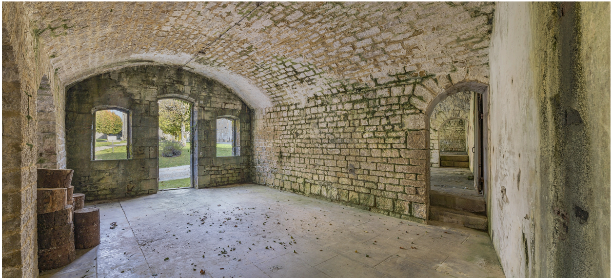
Salles casematées : vue traversante.
