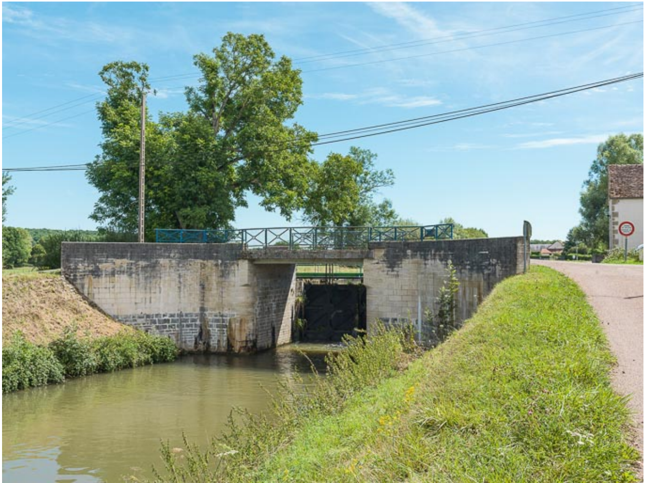
Vue du pont.
