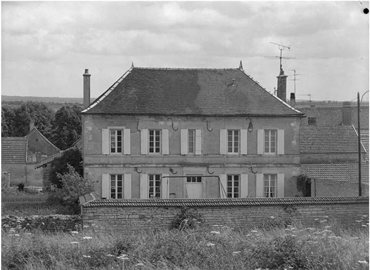
Façade sur cour.
