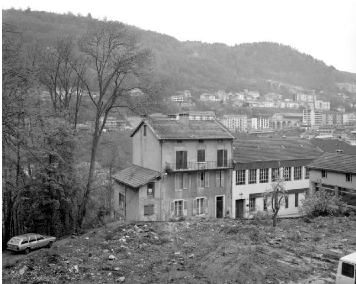
Vue d'ensemble de la façade antérieure.
