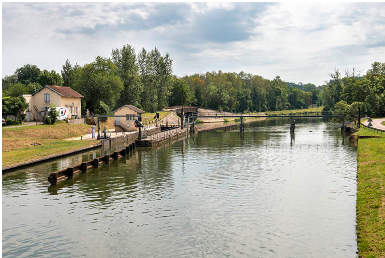
Le site d'écluse.
