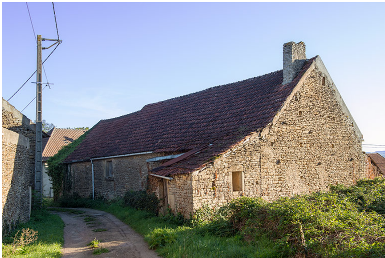
La ferme depuis la ruelle des grands prés, face nord-est.
