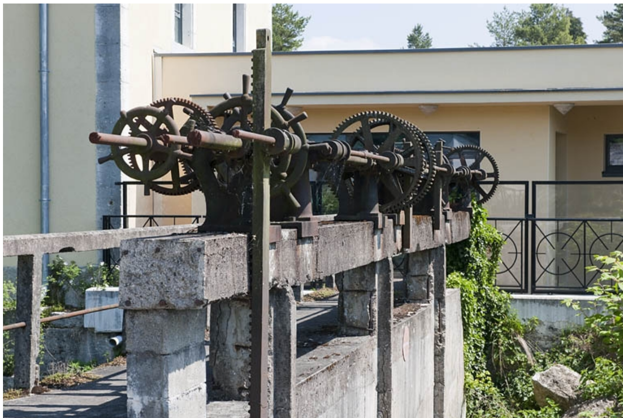
Système de vannage du bief de dérivation. Mécanisme de contrôle.
