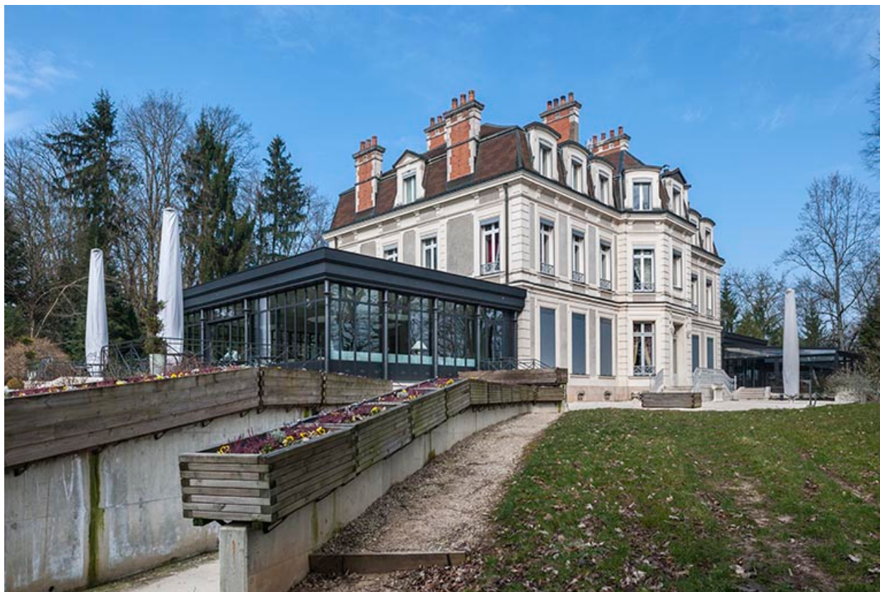
Logement patronal. Vue d'ensemble depuis le sud.
