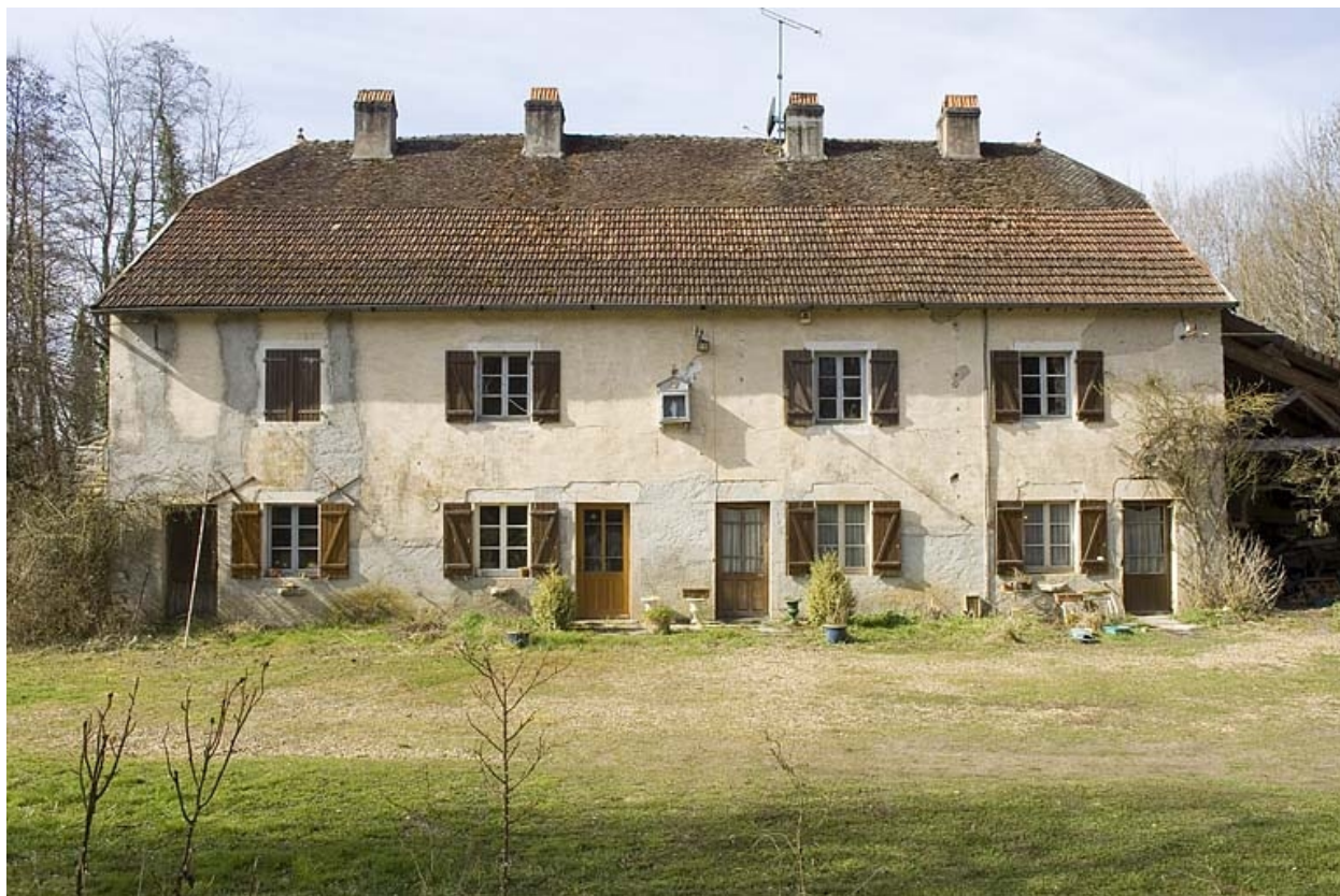
Logement d'ouvriers. Façade antérieure.
