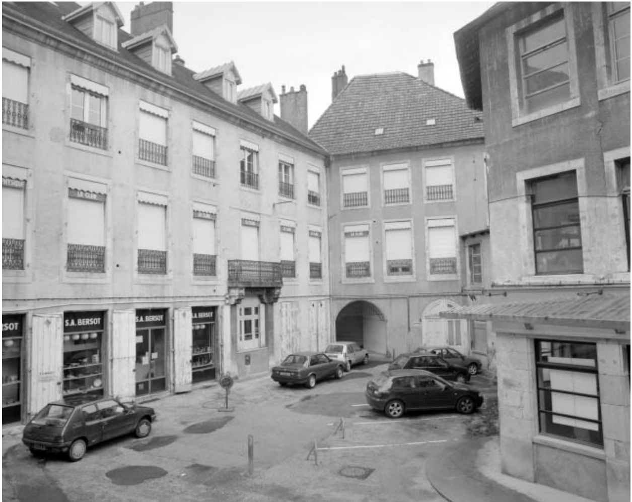
Façade postérieure du corps de logis sur cour, de trois quarts droit.
