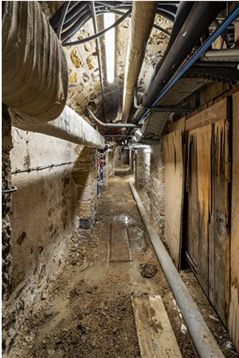
Galerie nord du sous-sol, sous le vestibule.
