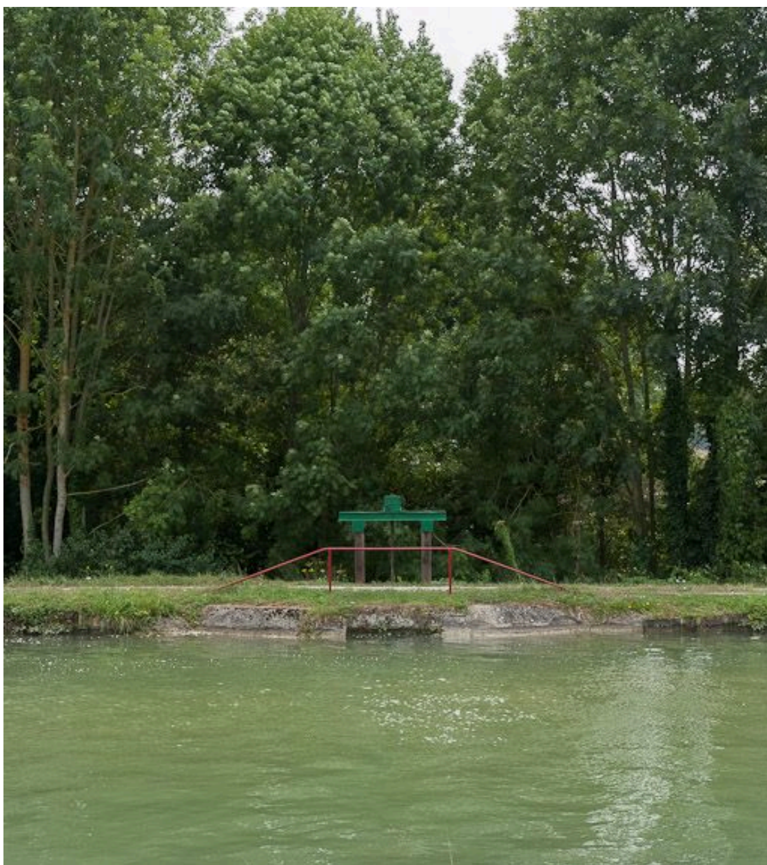
Vanne et déversoir vus du canal.
