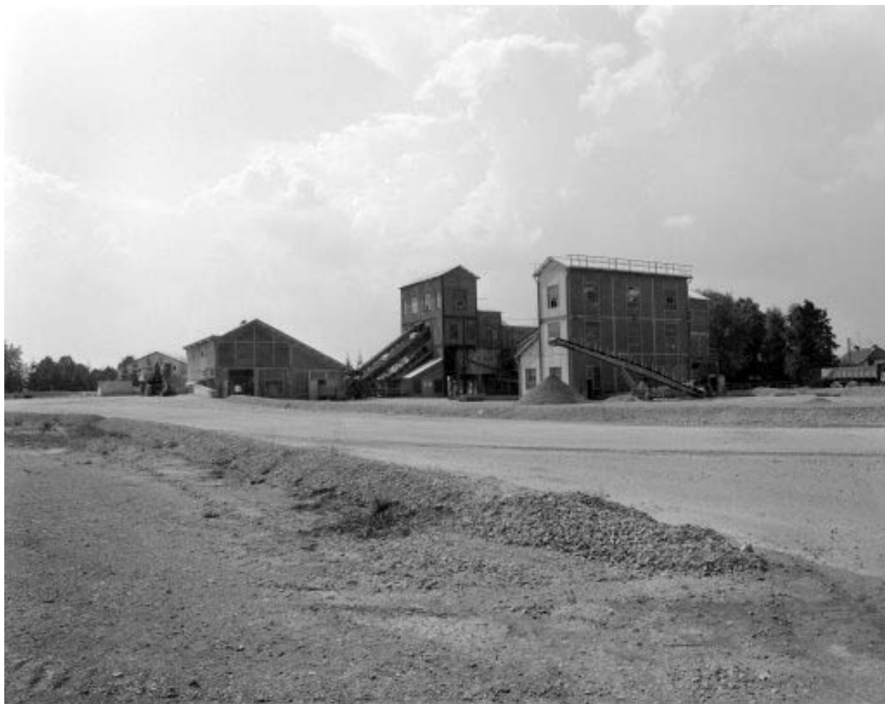
Bâtiments du broyeur (1) vus du nord-est.
