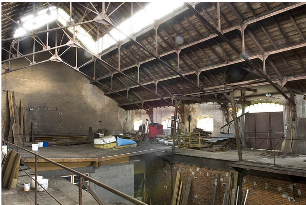
Partie ouest du comble.
