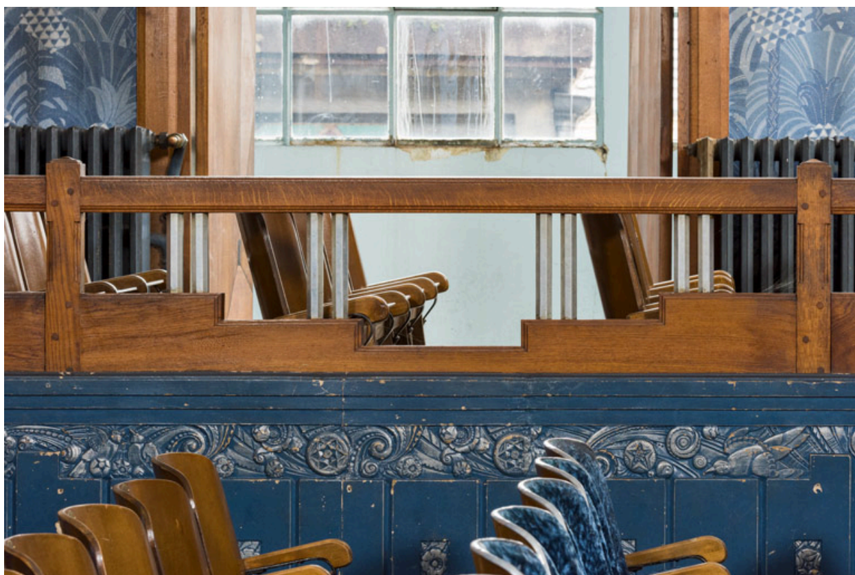
Salle, galerie côté jardin : détail du garde-corps.
