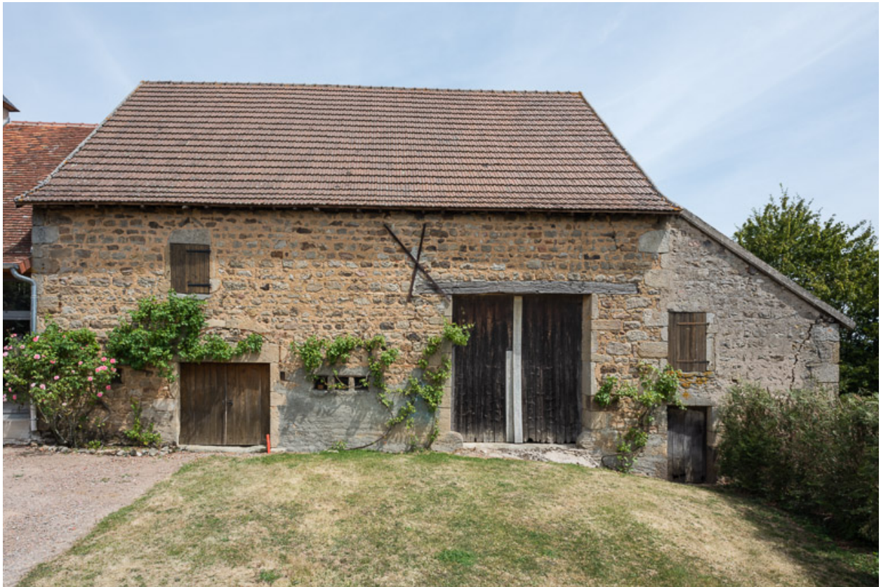
Façade antérieure de la grange, construite au XIXe siècle
