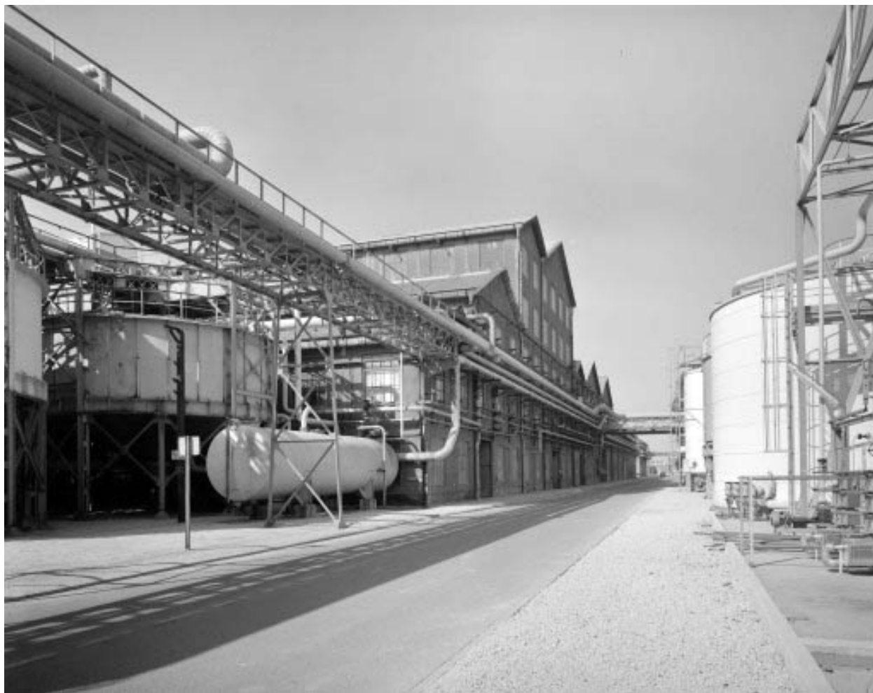
Bâtiment de la caustification (20) vu de l'est.
