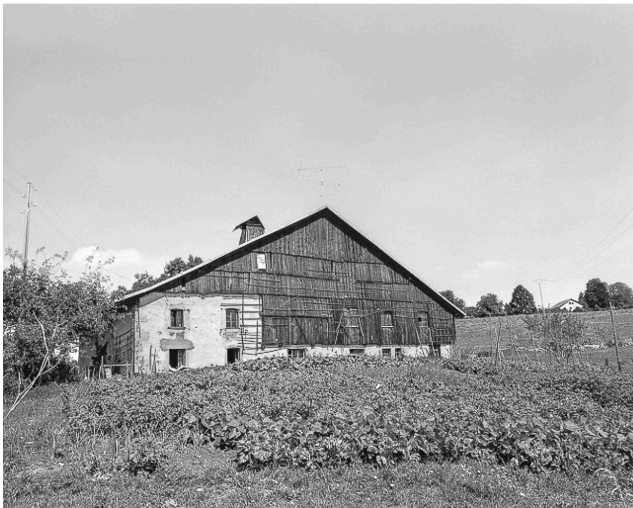
Ferme située au lieu-dit Pré Noë : façade antérieure.
