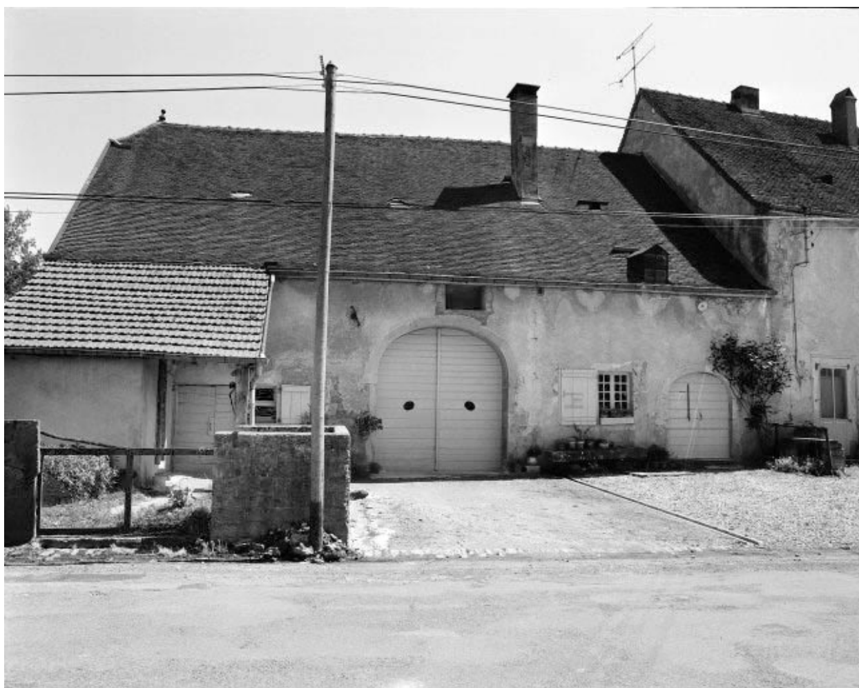
Ferme située rue d'Oisenans : façade antérieure.
