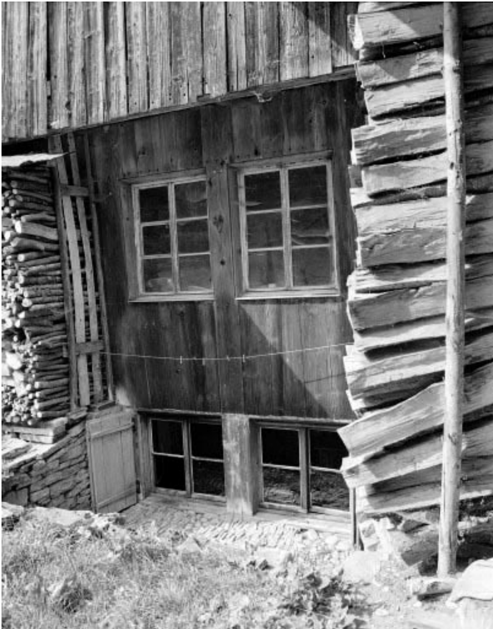
Façade postérieure : fenêtre de la cuisine.
