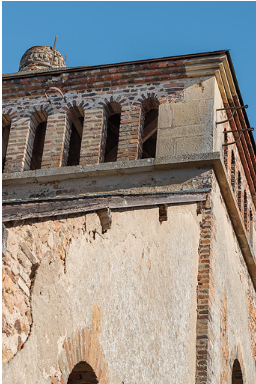
Claire-voie du quatrième niveau.
