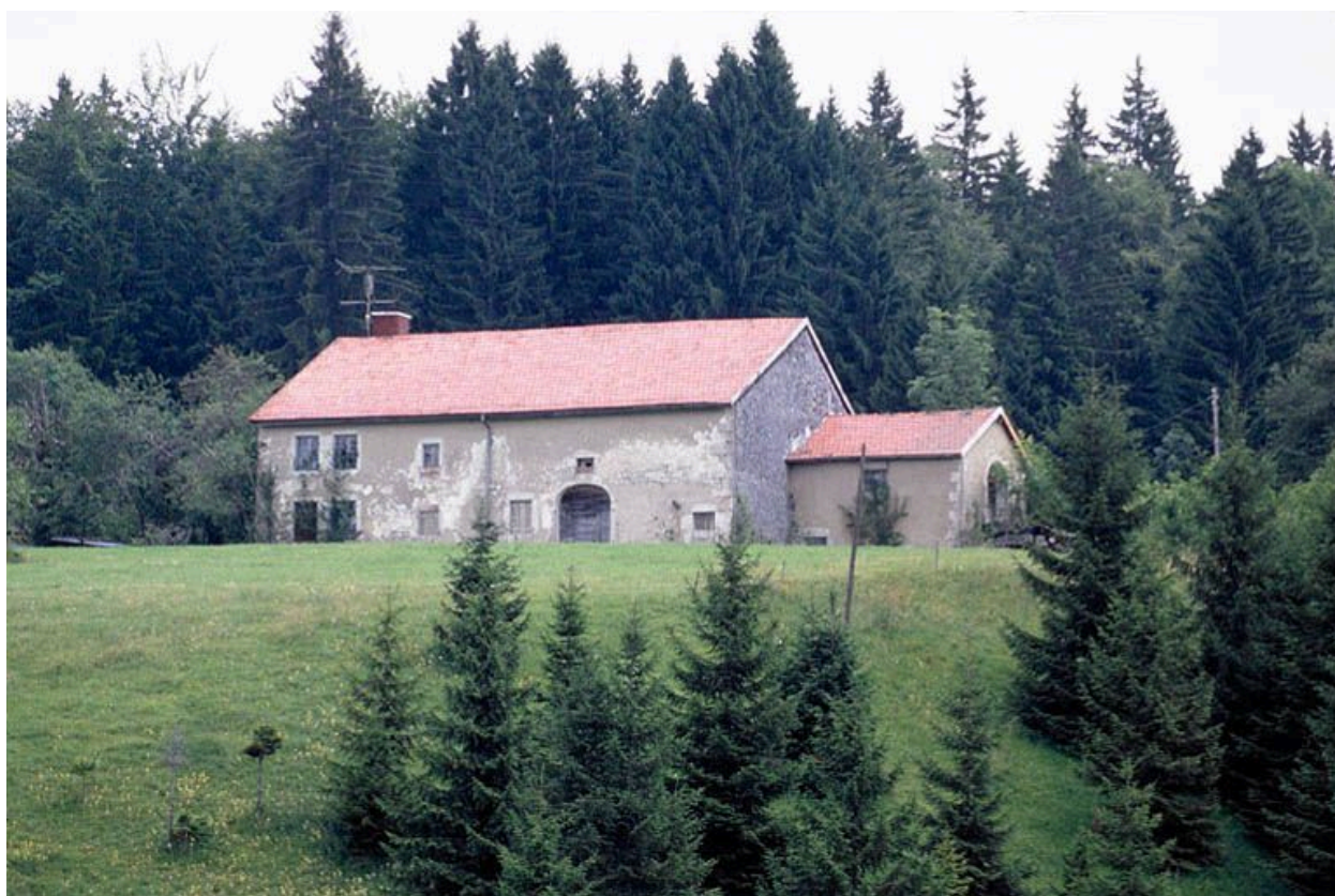
Vue éloignée de la façade postérieure.
