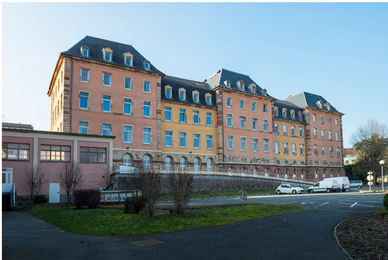
Lycée Condorcet : aile est du grand lycée.
