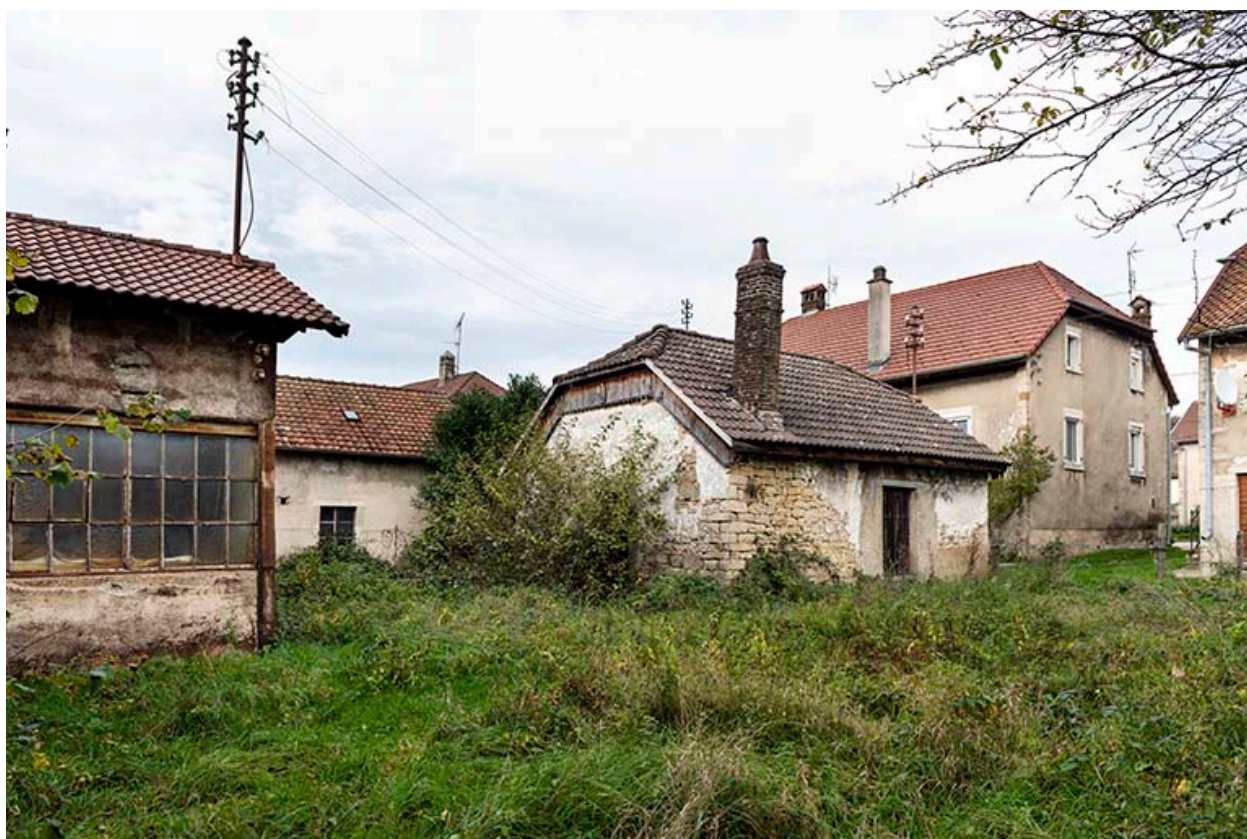
Forge : façades postérieure et latérale gauche.
