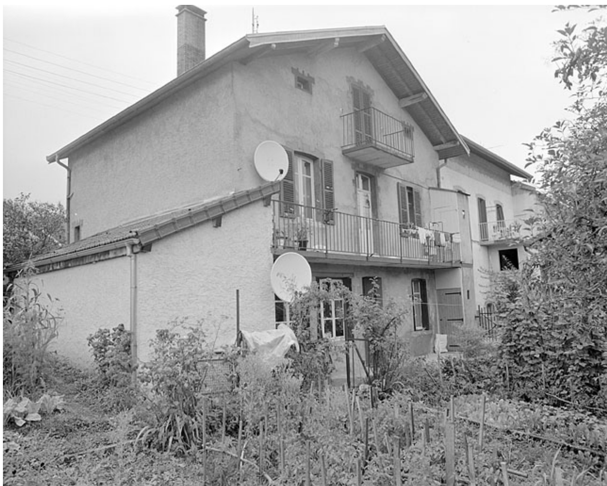
Façade postérieure et face sud.
