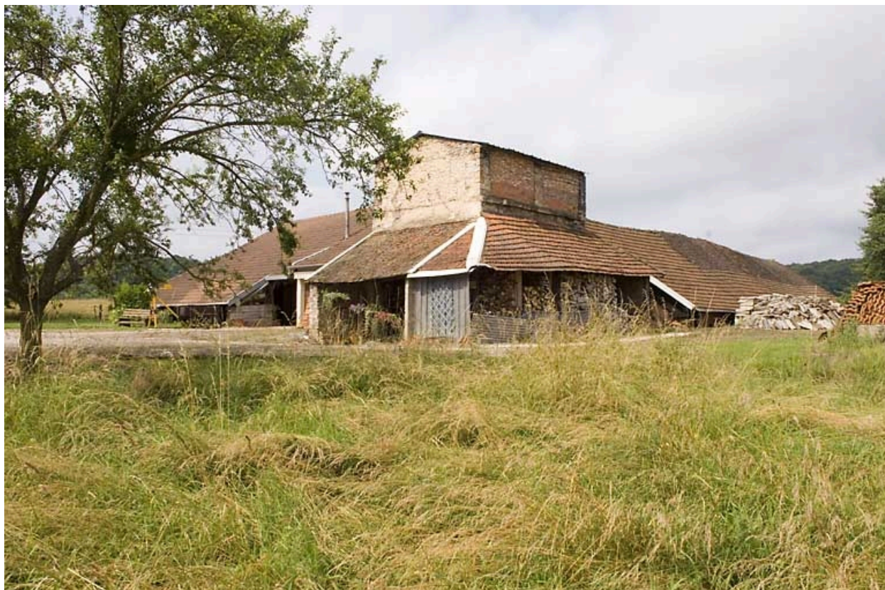
Tuilerie et briqueterie Janicot, Montureux-et-Prantigny. Le bâtiment du four s'élève à la jonction de l'atelier de fabrication (à gauche) et du séchoir (à droite).
