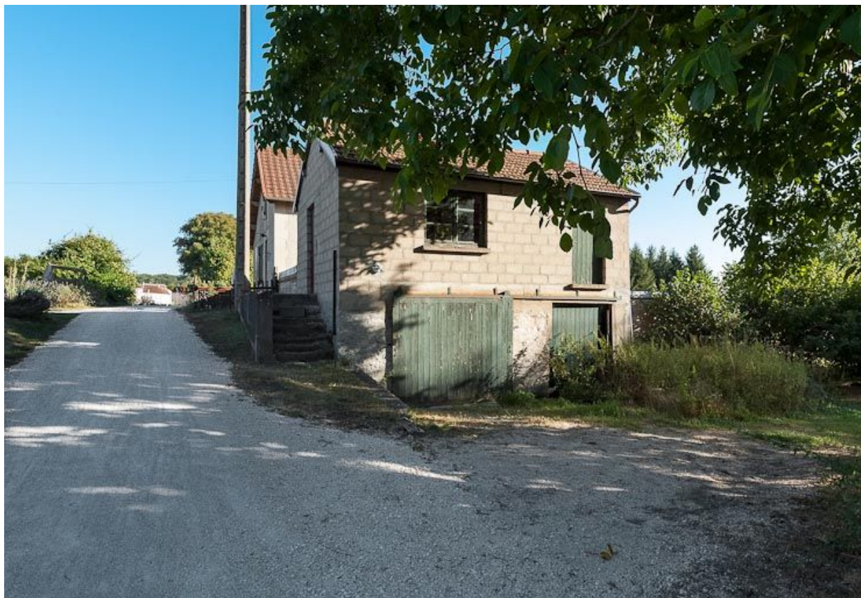
Les annexes à droite de la maison de garde.
