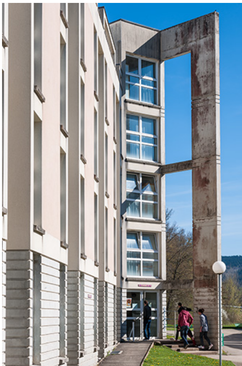
Internat : Détail de la façade antérieure.
