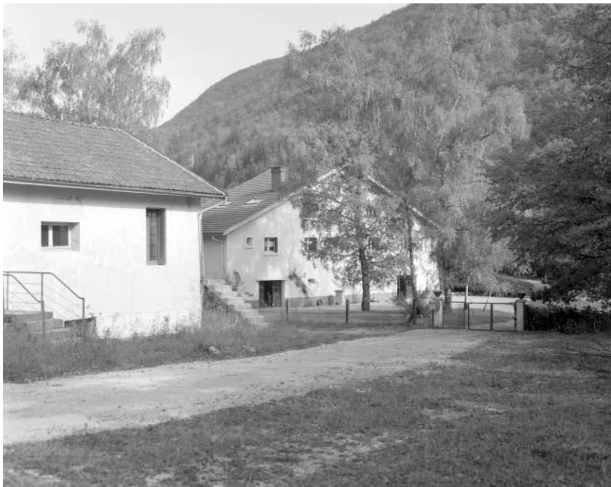
Logement de contremaître.
