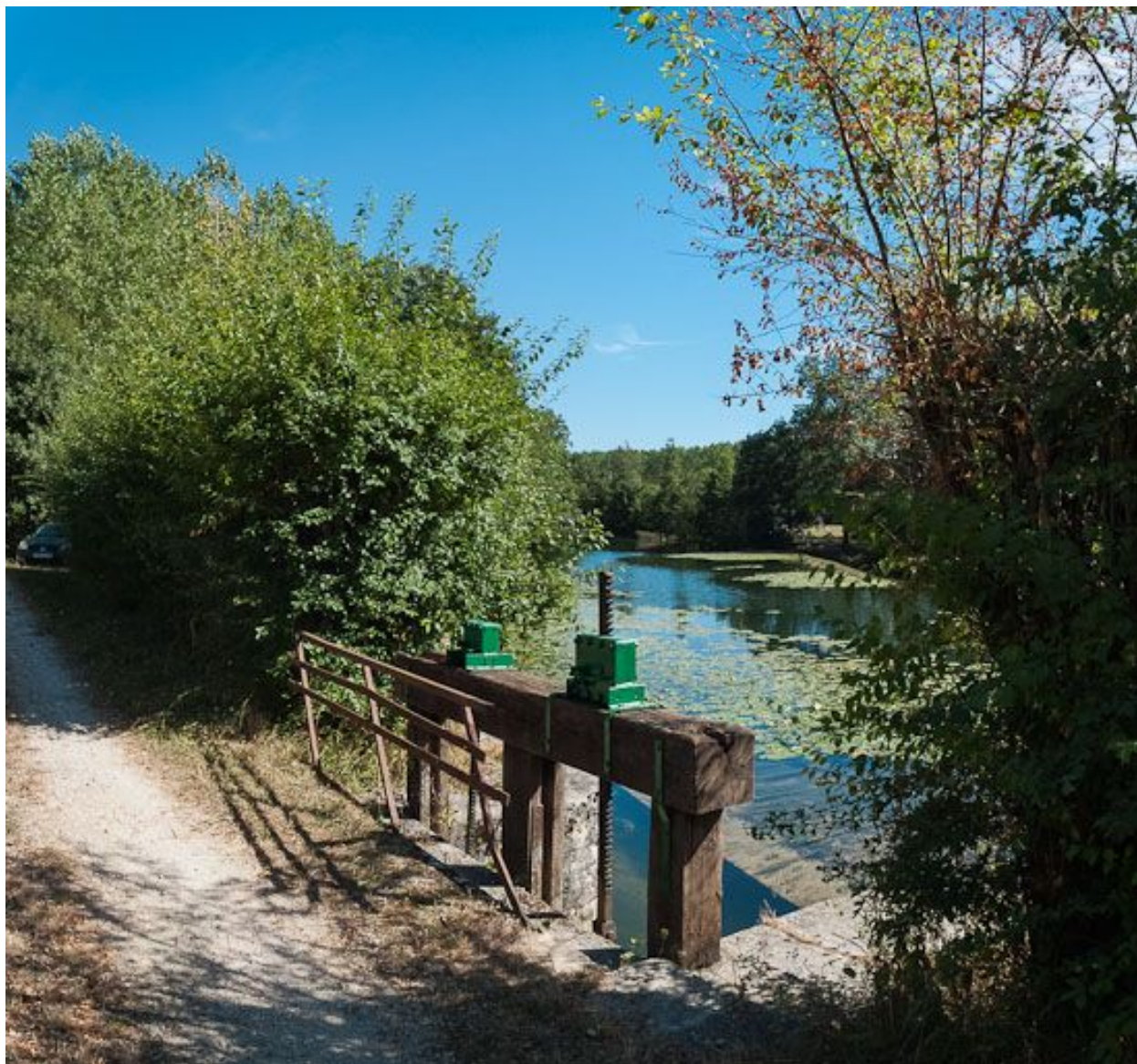
Détail des vannes.
