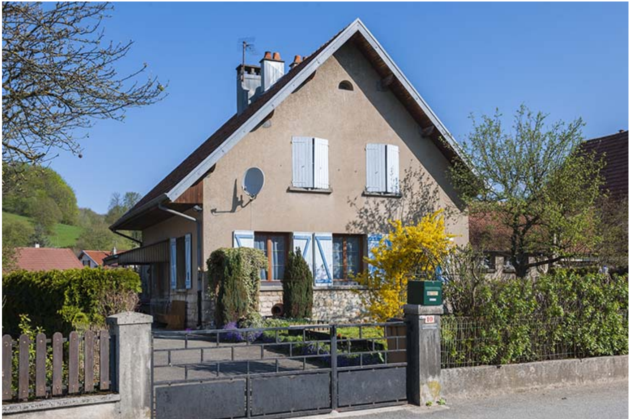
Façade antérieure d'une maison (rue des Ecoles).
