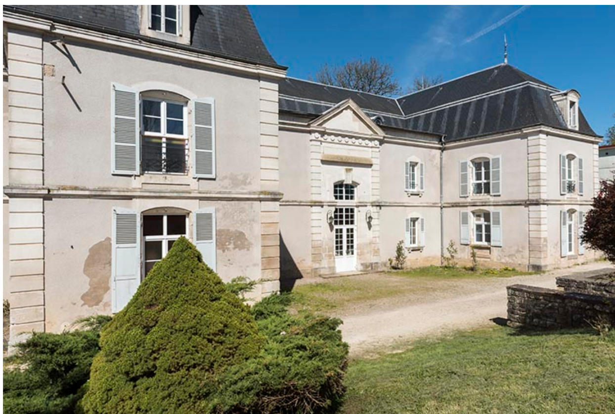
Les ailes symétriques et la travée principale.
