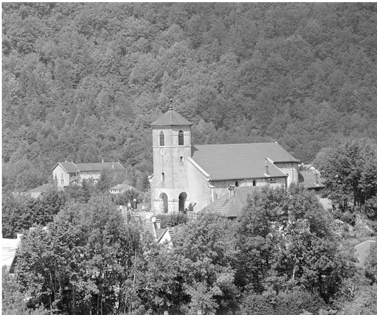
Vue de situation depuis le sud-ouest.
