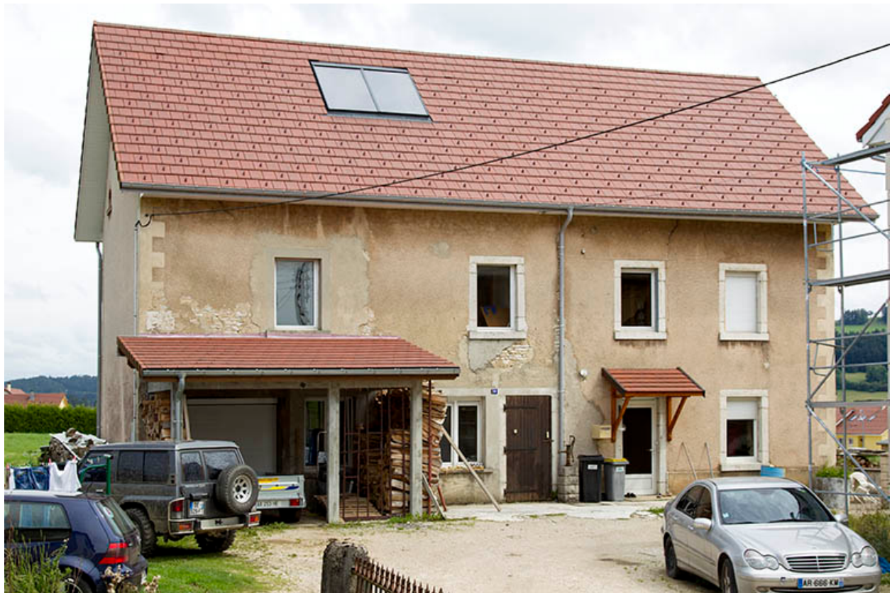
Bâtiment au n° 39 : façade antérieure.
