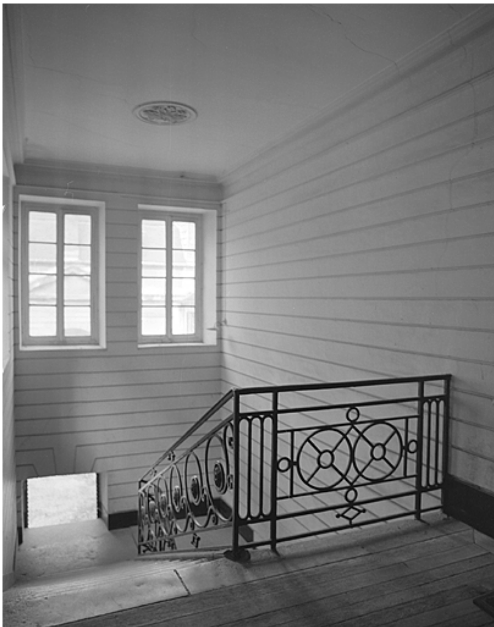
Vue de l'escalier depuis le palier.
