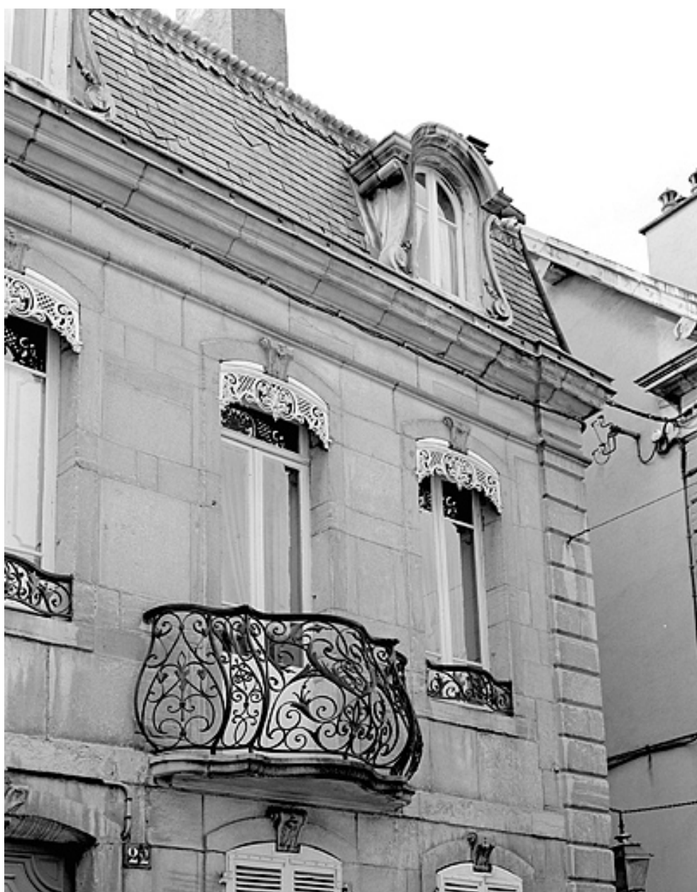
Façade antérieure, balcon.
