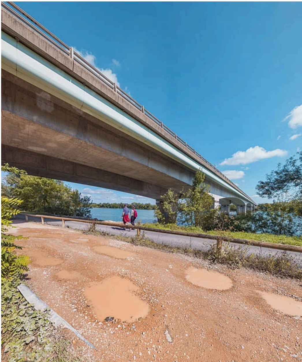
Le pont depuis la véloroute, rive droite.
