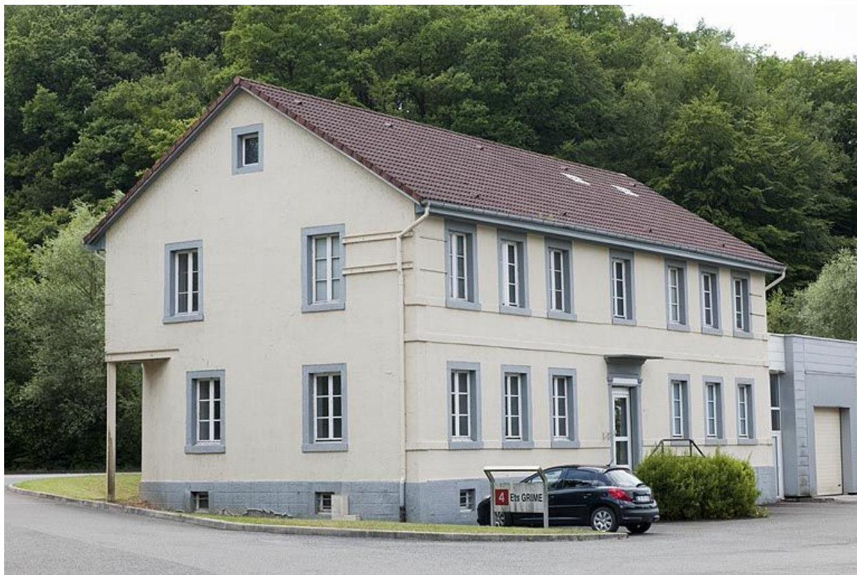
Ancien bâtiment des bureaux. Façade nord.
