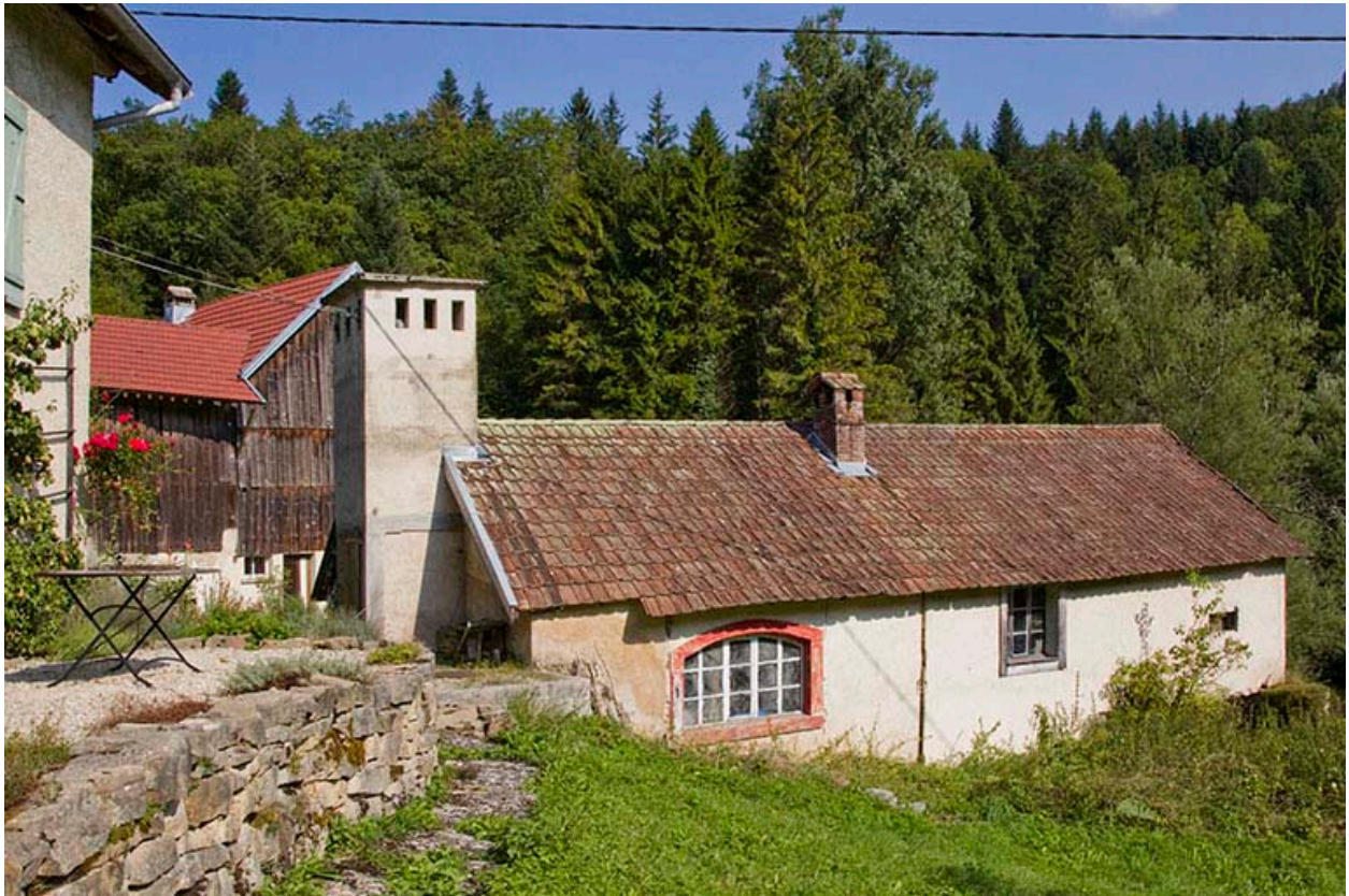
Centrale : façade postérieure, de trois quarts gauche.
