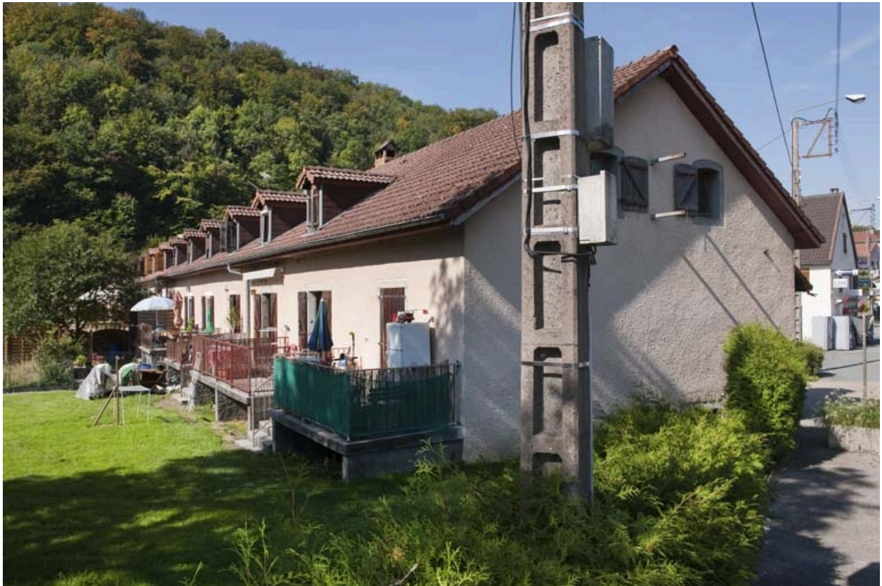
Caserne G. Façade postérieure vue depuis l'est.
