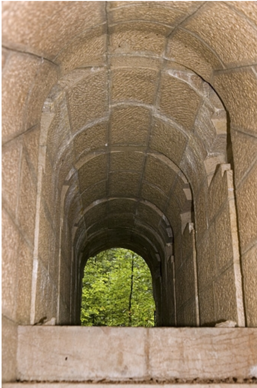
Chambres de mine centrale : galerie supérieure, vue depuis l'escalier.
