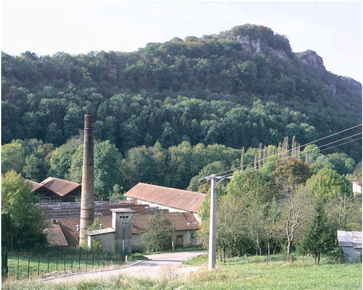
Vue des toitures depuis le nord.
