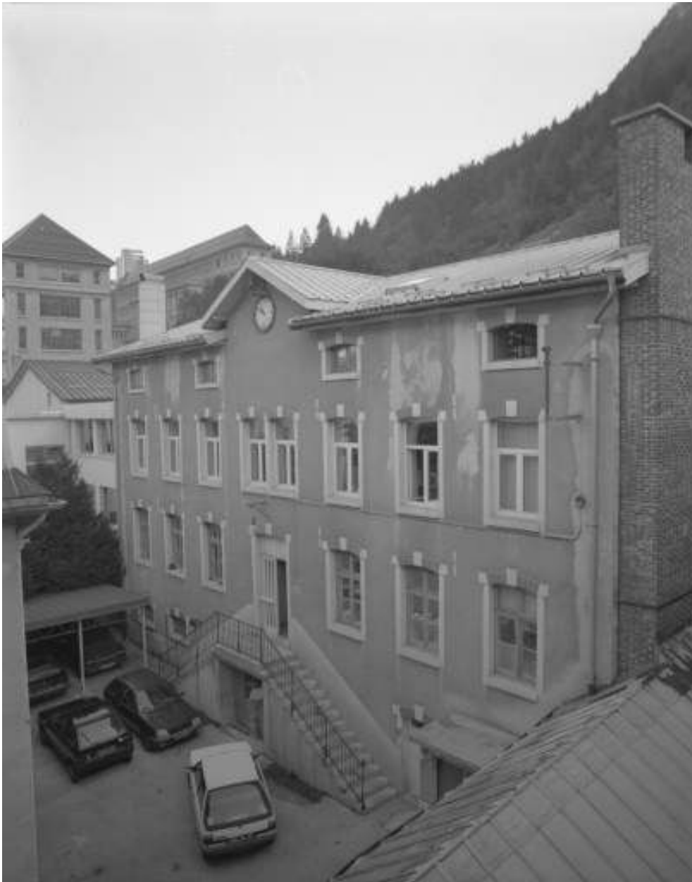
Site ancien : façade antérieure de l'usine, de trois quarts droite.
