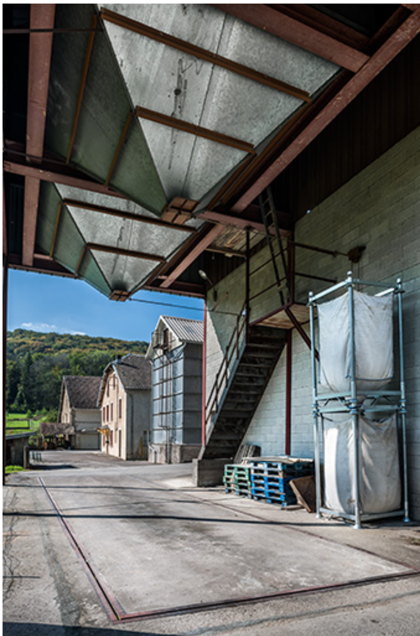
Vue depuis le pont bascule.
