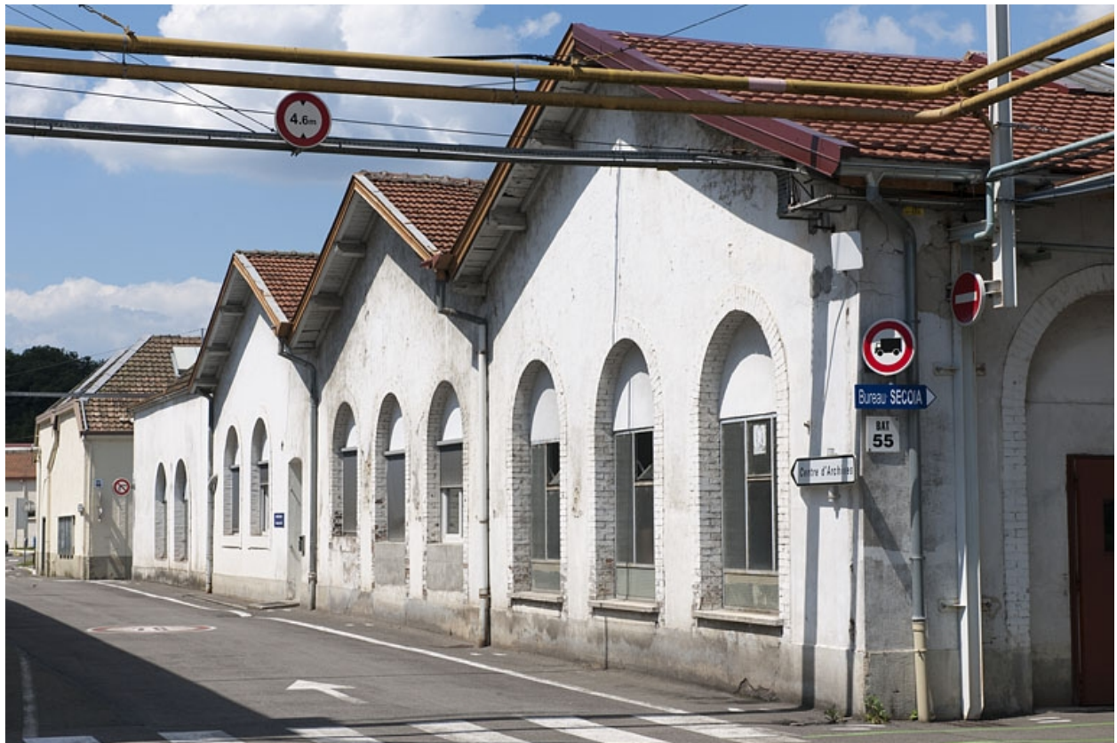
Pignons ouest de l'atelier de maintenance.
