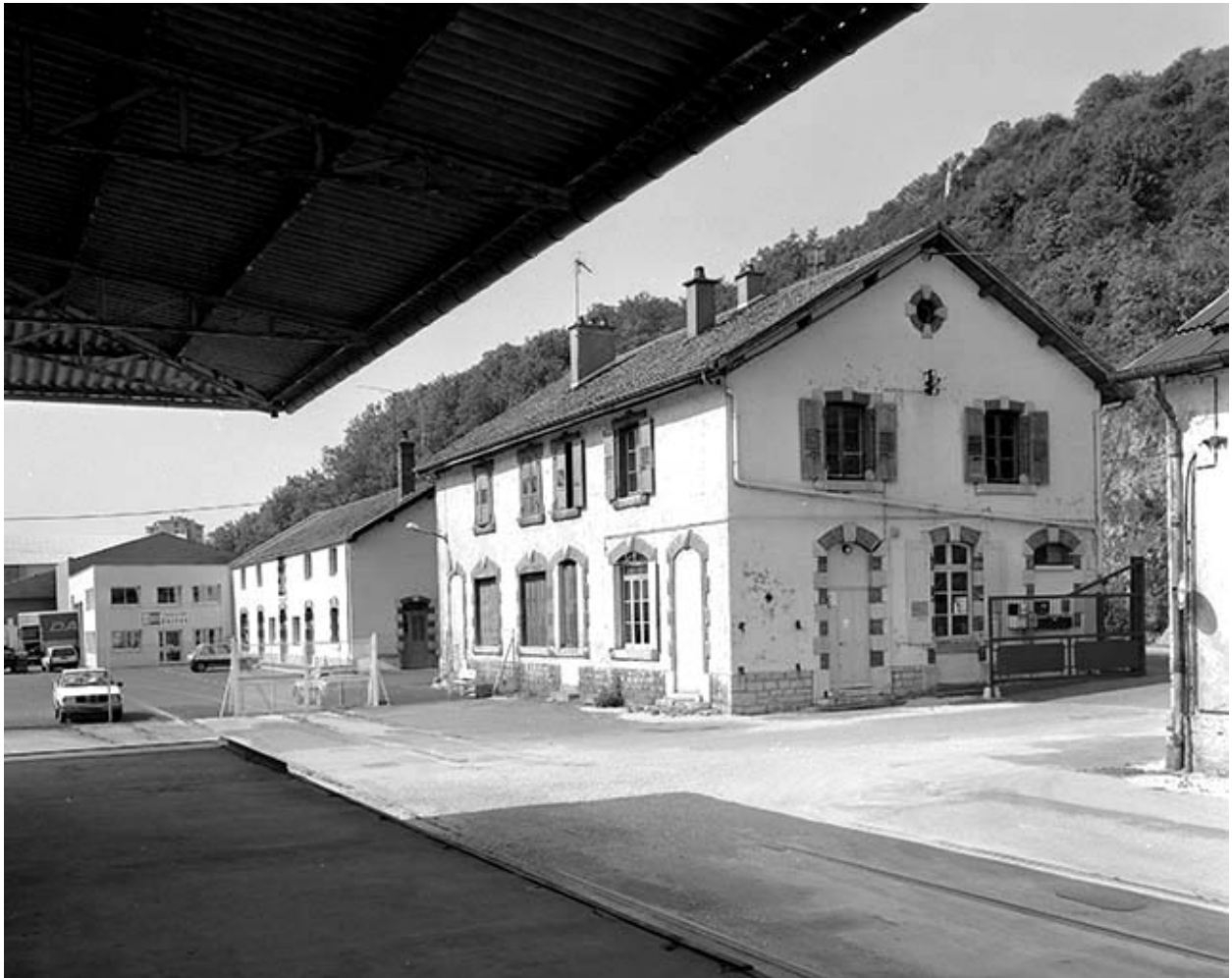
Usine B : entrepôt de matériel et logements, de trois quarts droit.
