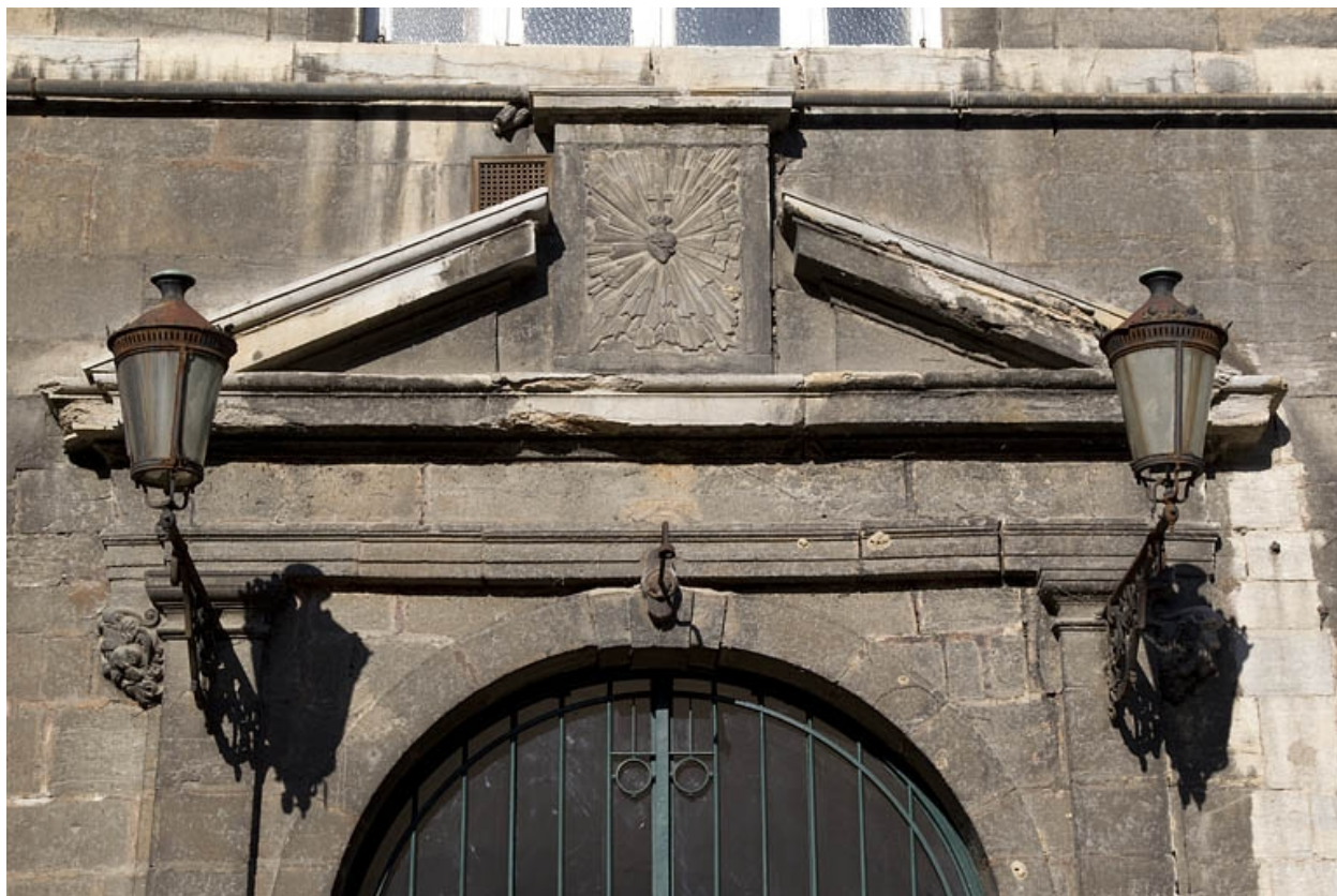
Façade antérieure, portail d'entrée : détail du fronton.
