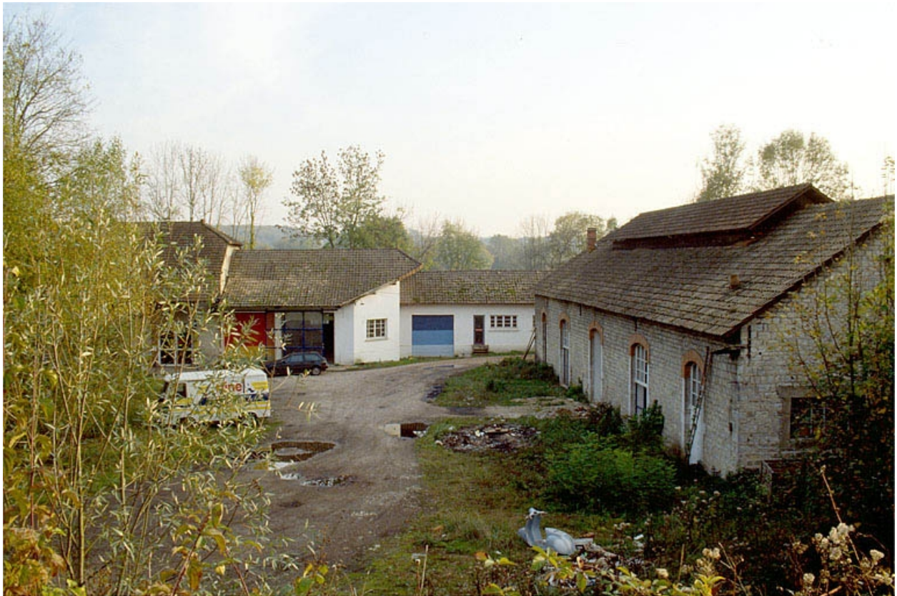
Magasin industriel (E) et atelier de réparation.
