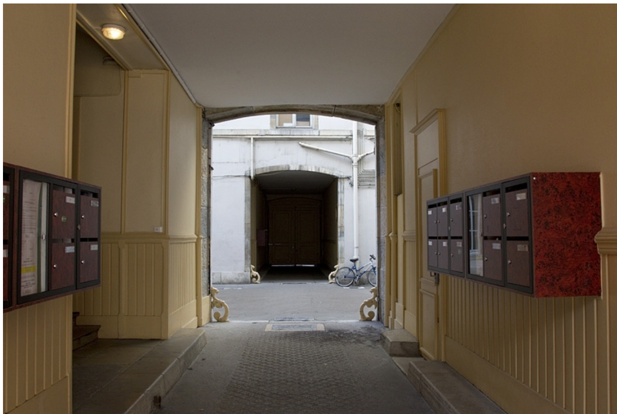
Vue d'ensemble des passages cochers en enfilade.
